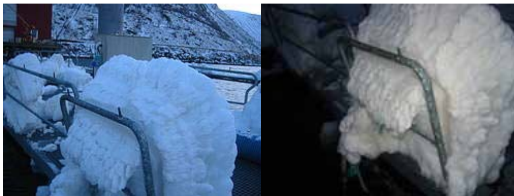
Figur 5 Ising på stålanlegg (bilde hentet fra http://www.flextech.no ).
